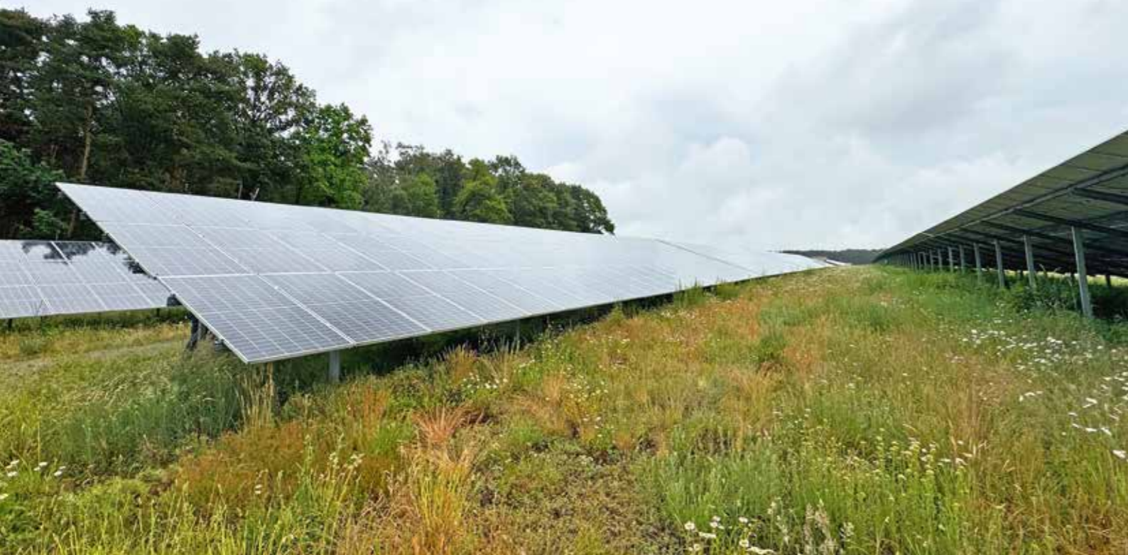
Unter PV-Modulen kann sich Vegetation entwickeln und Regenwasser versickern. Foto: Ralf Hennig
