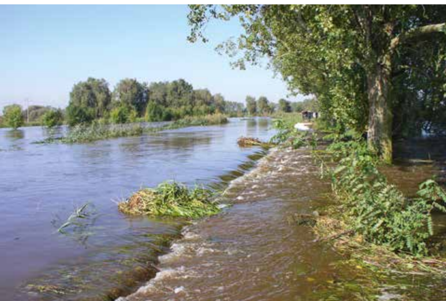
Deichüberströmung an der Schwarzen Elster im Hochwasser 2010. Foto: Angela Purz/LFU
