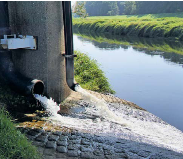
Abb. 4.1.1: Einleitung von mangan- und ammoniumstickstoffhaltigen Sumpfungswässern aus dem Tagebaurestloch Lochau in die Weiße Elster, September 2023. Foto: W. Kleinsteuber
